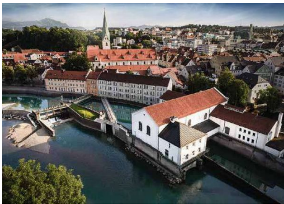
Wasserkraftwerk Illerstraße Kempten
