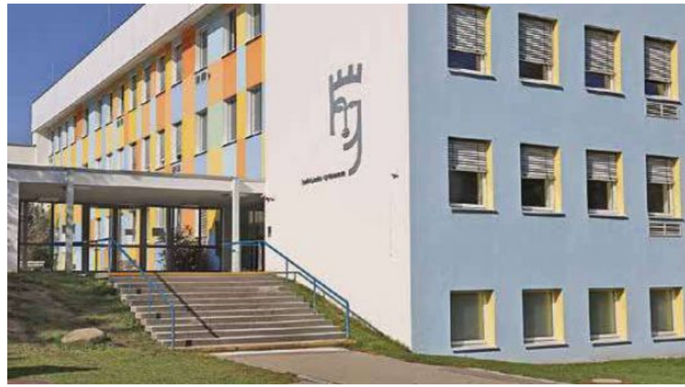
Hereinspaziert: Das Hildegardis-Gymnasium ist als Klimaschutzschule bundesweit bekannt. Foto: Matthias Becker
